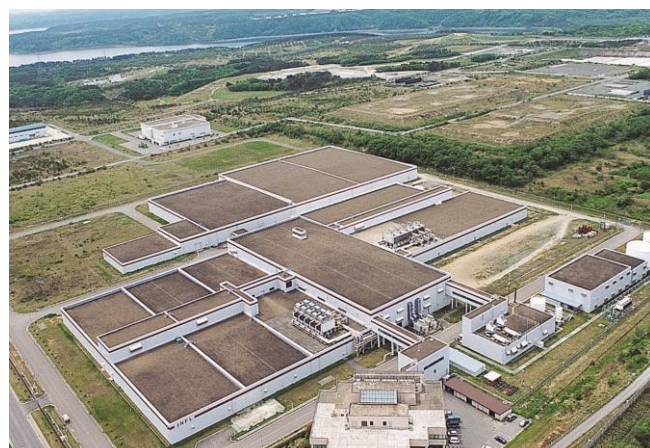
ウラン濃縮施設
