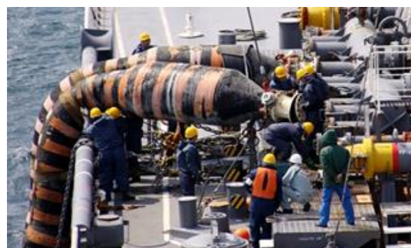
マリンホース取付作業
