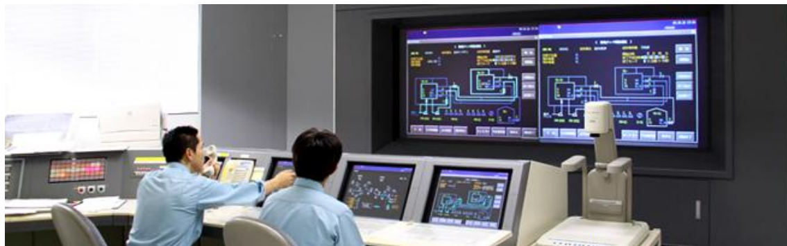
計器室での運転及び監視業務
