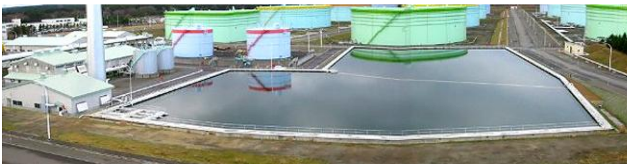
貯蔵基地貯水槽
