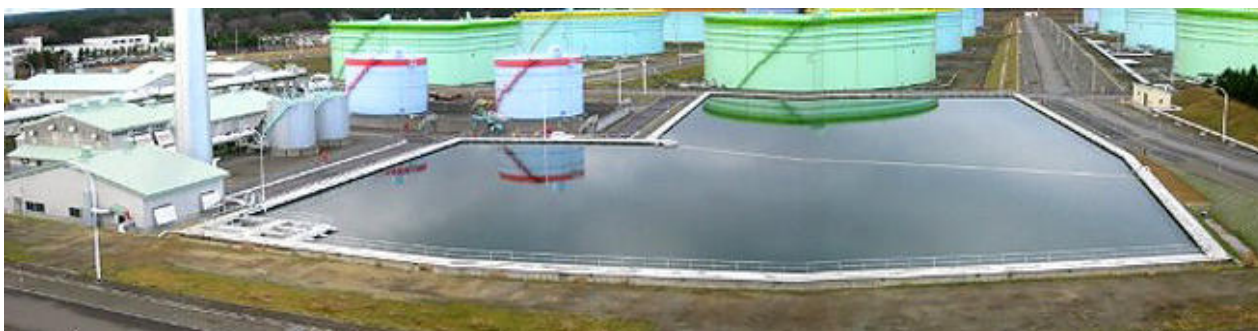
貯蔵基地貯水槽
