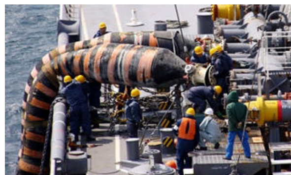
マリンホース取付作業
