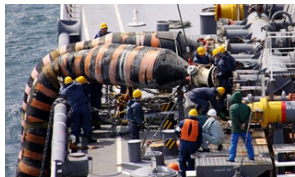
マリンホース取付作業
