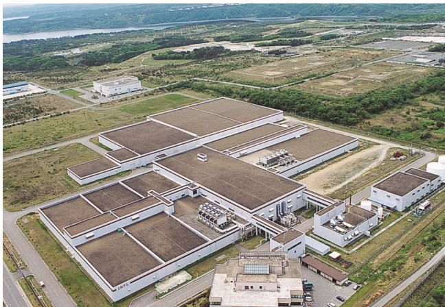
ウラン濃縮施設
