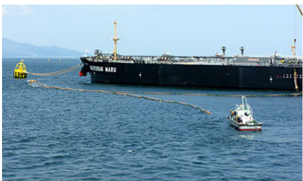
オイルフェンス展張作業
