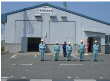
・正面から見た「屋内消防訓練所」概観
