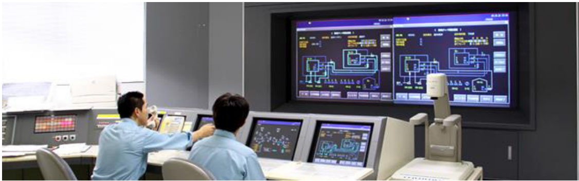
計器室での運転及び監視業務
