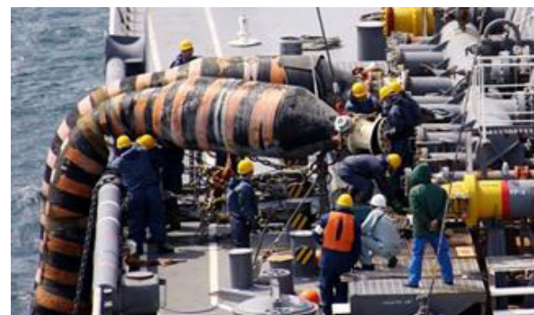
マリンホース取付作業
