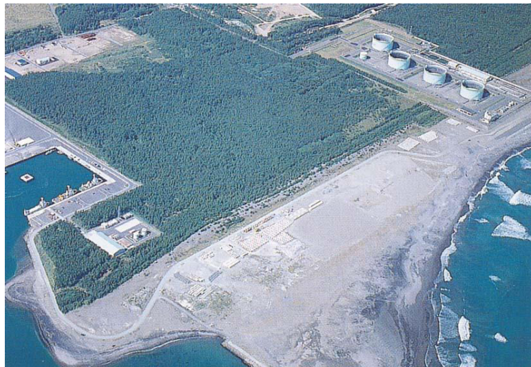
中継ポンプ場（右上） 作業船管理場（左下）
