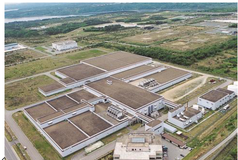
ウラン濃縮施設
