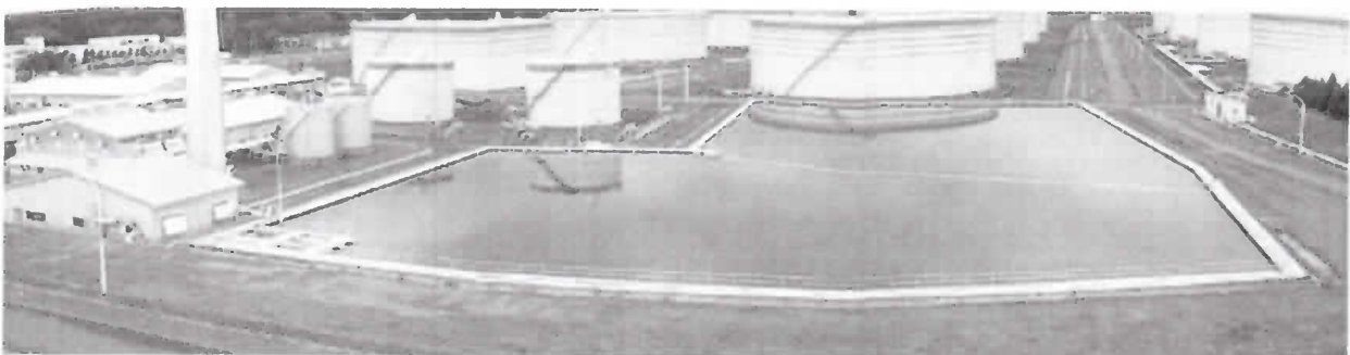
貯蔵基地貯水槽
