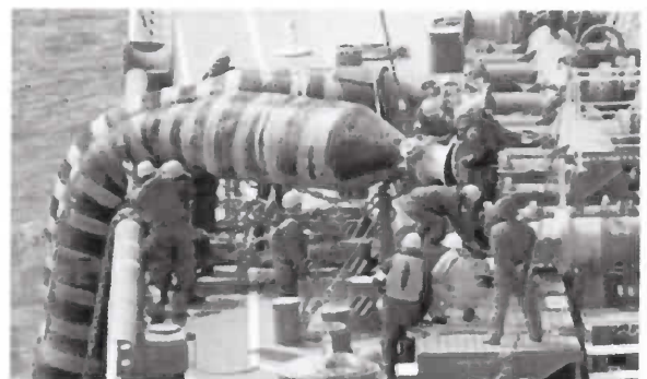
マリンホース取付作業
